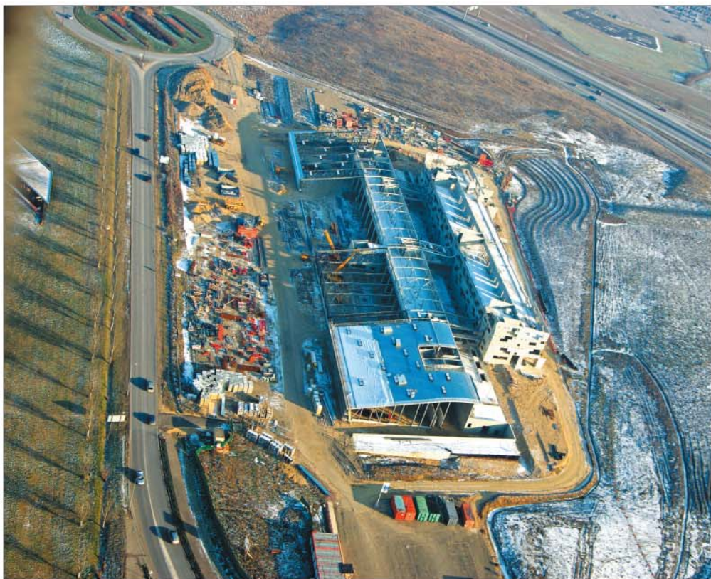
Le chantier de la nouvelle Enim.
