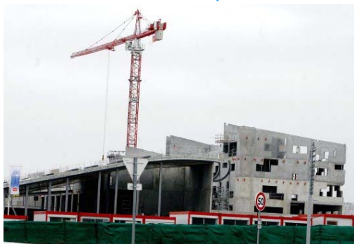
Le chantier de la nouvelle Enim avance de façon spectaculaire au Technopôle.
